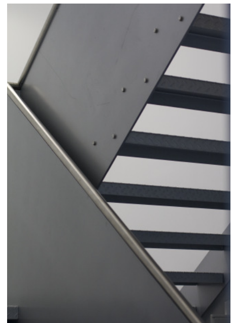
die neue Metalltreppe führt ins Obergeschoss
