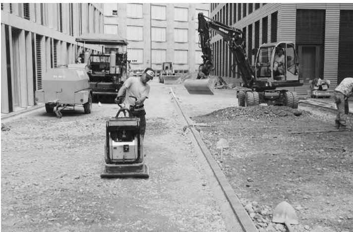
Strassenplanie-Arbeiten als Vorbereitung für den Deckbelag
