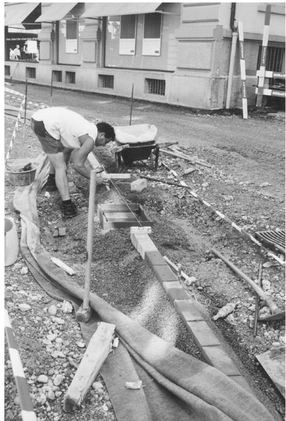
Rote Mittelentwässerungsrinne als Bestandteil der Strassenraumgestaltung
