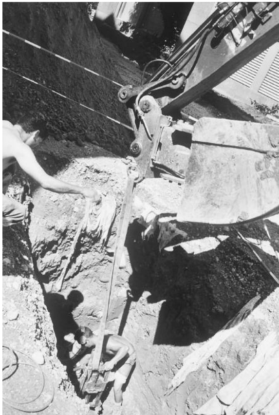
Neuer Kanalanschluss für die Strassenentwässerung
