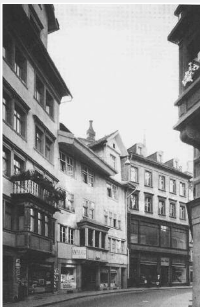
Spisergasse von Osten, 1957. Beim dritten Haus von links mit den Schaufensterfronten im Erd- und ersten Obergeschoss ereignete sich der Unfall.
