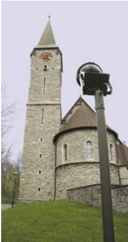
Fassadenbeleuchtung eines öffentlichen Gebäudes ...
