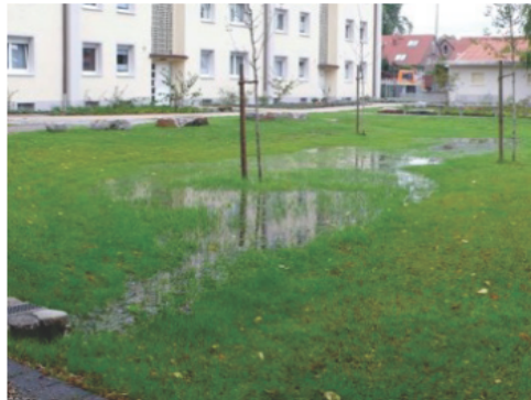
Beispiel Muldenversickerung (Quelle: www.fpg-herne.de )
