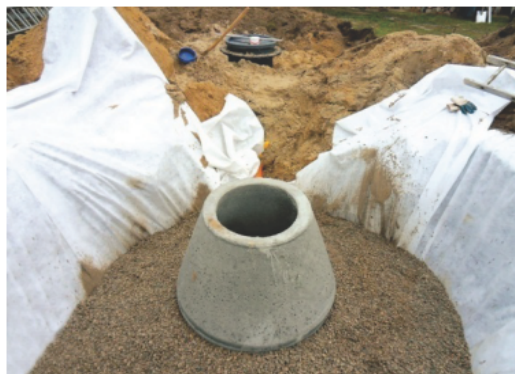
Beispiel Schachtversickerung (Quelle: www.shk-profi.de )
