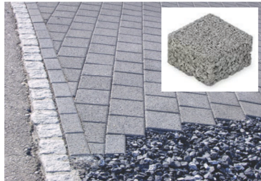
Beispiel Flächenversickerung (Quelle: www.betonchristen.ch )
