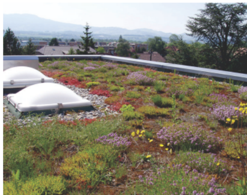
Flachdach extensiv begrünt (Quelle: www.wickidach.ch )
