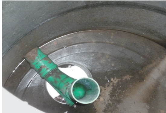
Abflussdrossel mit Notüberlauf (Quelle: Amt für Umwelt TG)
