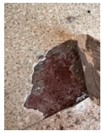
EG Küche Bodenfliese unter PVC in Mörtel ohne Kleber
