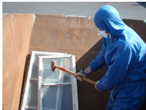
1 Ausglasen mit einem Hammer
