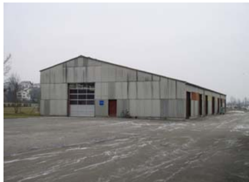
1 Mit Wellplatten aus Faserzement verkleidete Industriehalle
