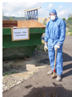
2 Arbeiter mit korrekter persönlicher Schutzausrüstung
