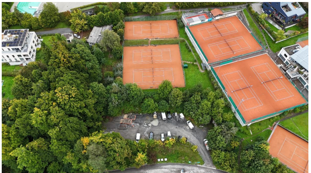
Abb. 1: Luftaufnahme, Blick in Richtung Nordosten, 25.09.2025
