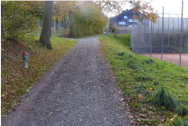
Abb. 3: Klosterweidlistrasse, Blick Richtung Süden
