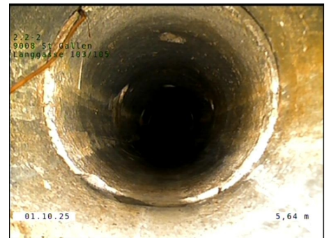
Pos: 11 - 12; Einzelner, feiner Wurzeleinwuchs, Querschnittsreduzierung = 0%
