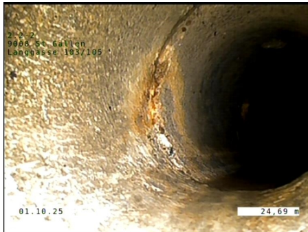
Pos: 3; Bogen nach rechts, Winkel = 30°
