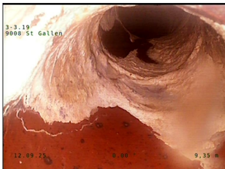
Pos: 2 - 3; Anschluss mit Formstück, Höhe = 0mm
