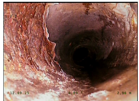
Rohrmaterialwechsel: Duktiler Guss
