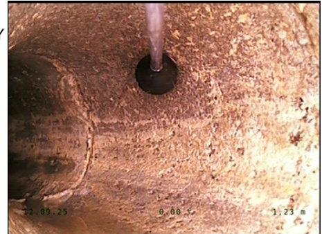
Pos: 9; Bogen nach links, Winkel = 45°
