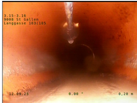
Wasserspiegel, Abwasser klar, Höhe = 10%
