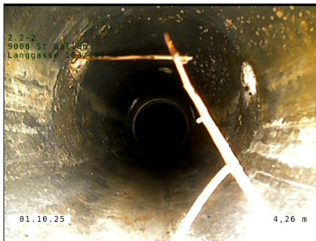
Pos: 10 - 11; Einzelner, feiner Wurzeleinwuchs, Querschnittsreduzierung = 0%
