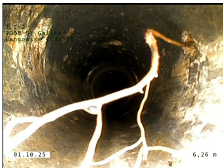
Pos: 1; Einzelner, feiner Wurzeleinwuchs, Querschnittsreduzierung = 0%
