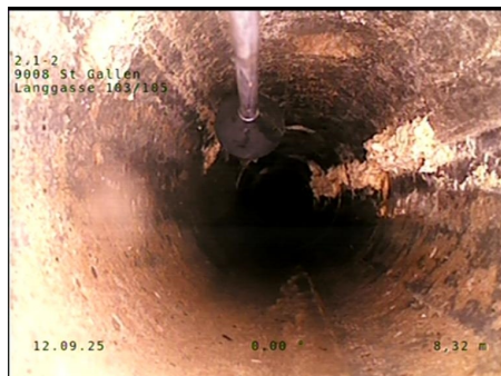
Wasserspiegel, Abwasser klar, Höhe = 3%
