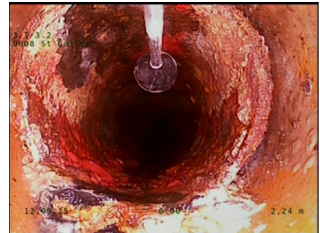
Rohrmaterialwechsel: Duktiler Guss
