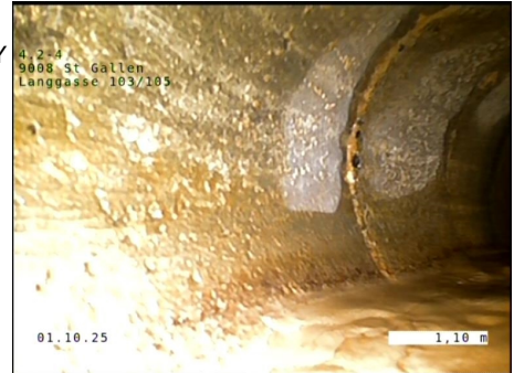
Pos: 3; Bogen nach rechts, Winkel = 30°
