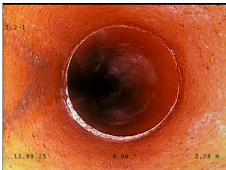
Pos: 9; Anschluss mit Formstück, Höhe = 0mm
