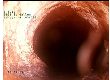
Pos: 7 - 4; Inkrustation, Querschnittsreduzierung = 0%
