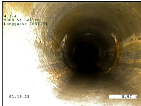
Wasserspiegel, Abwasser klar, Höhe = 20%
