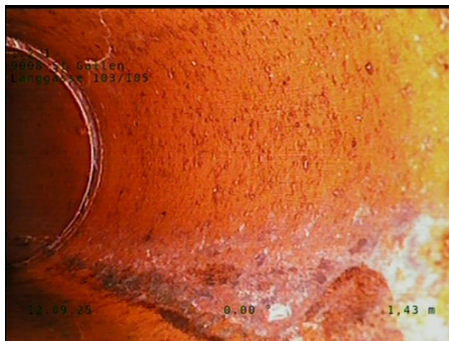
Pos: 9; Bogen nach links, Winkel = 45°
