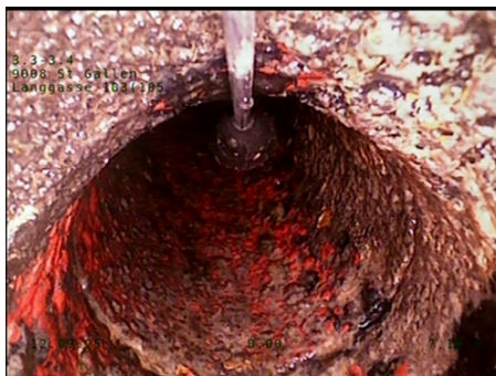
Abbruch der Inspektion, Fallstrang erreicht
