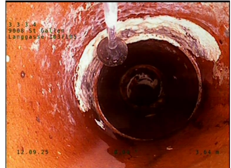
Pos: 9 - 3; Inkrustation, Querschnittsreduzierung = 0%
