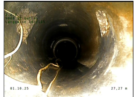
Pos: 10; Einzelner, feiner Wurzeleinwuchs, Querschnittsreduzierung = 0%
