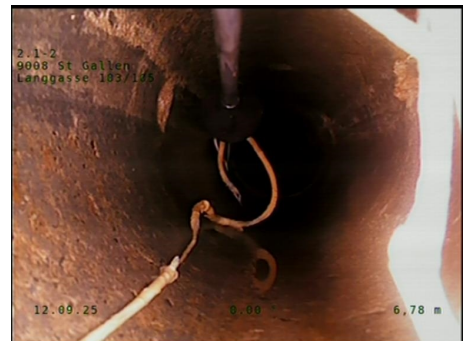
Pos: 5 - 7; Einzelner, feiner Wurzeleinwuchs, Querschnittsreduzierung = 0%, Teilweise ganze Haltung, Fotobeispiel
