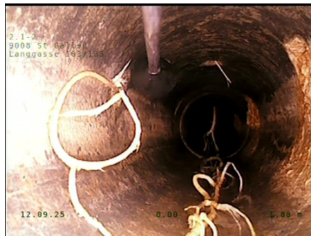
Pos: 6 - 12; Einzelner, feiner Wurzeleinwuchs, Querschnittsreduzierung = 0%
