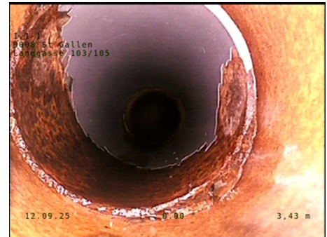
Rohrmaterialwechsel: Duktiler Guss
