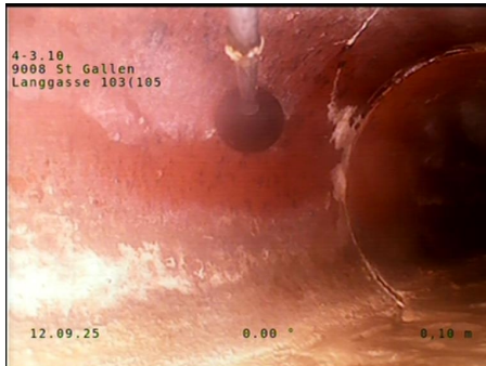
Pos: 3; Bogen nach rechts, Winkel = 30°
