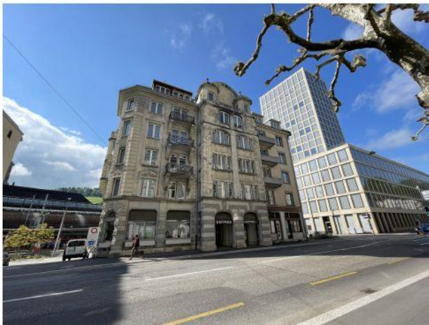
Haus Montana, Rosenbergstr. 55, SG 13.05.2025 Fassaden IMG_8681 Nord
