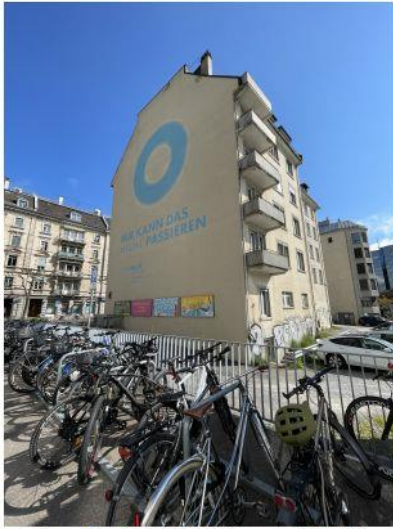
Haus Montana, Rosenbergstr. 55, SG 13.05.2025 Fassaden IMG_8678 West
