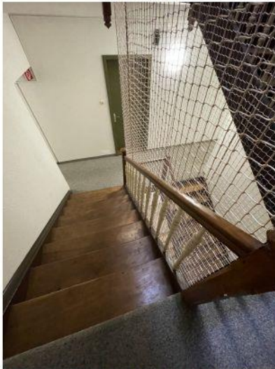
Haus Montana, Rosenbergstr. 55, SG 13.05.2025 Treppenhaus IMG_8714
