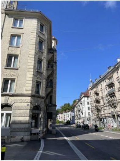
Haus Montana, Rosenbergstr. 55, SG 13.05.2025 Fassaden IMG_8685 Ost
