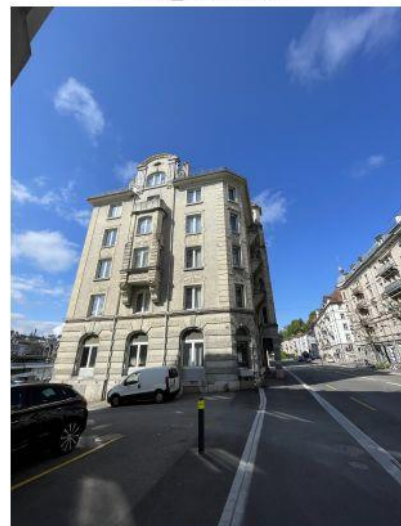
Haus Montana, Rosenbergstr. 55, SG 13.05.2025 Fassaden IMG_8684 Ost
