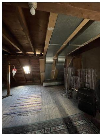
Haus Montana, Rosenbergstr. 55, SG 13.05.2025 DG IMG_8696
