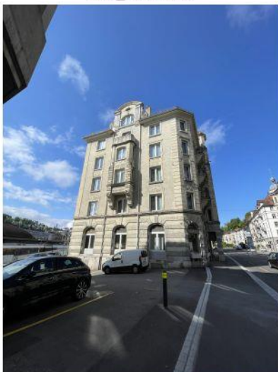
Haus Montana, Rosenbergstr. 55, SG 13.05.2025 Fassaden IMG_8683 Ost
