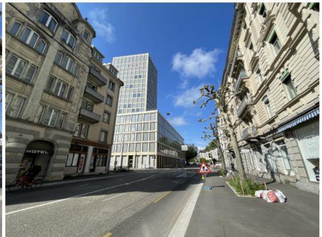
Haus Montana, Rosenbergstr. 55, SG 13.05.2025 Fassaden IMG_8682 Nord
