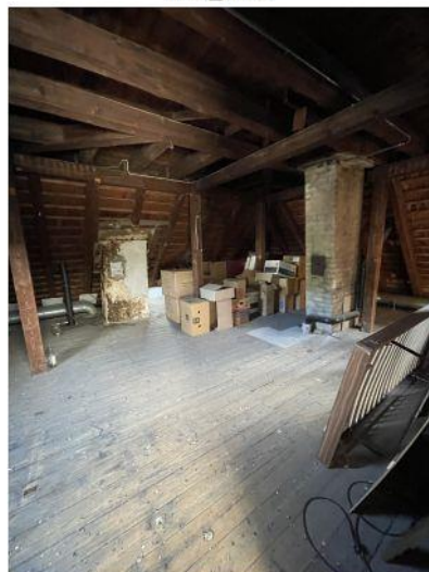
Haus Montana, Rosenbergstr. 55, SG 13.05.2025 DG IMG_8700
