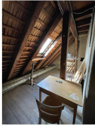
Haus Montana, Rosenbergstr. 55, SG 13.05.2025 DG IMG_8702
