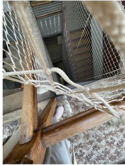
Haus Montana, Rosenbergstr. 55, SG 13.05.2025 Treppenhaus IMG_8694
