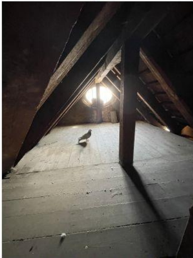
Haus Montana, Rosenbergstr. 55, SG 13.05.2025 DG IMG_8703
