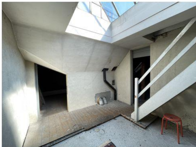
Haus Montana, Rosenbergstr. 55, SG 13.05.2025 DG IMG_8699
