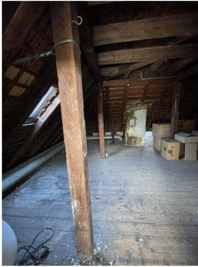
Haus Montana, Rosenbergstr. 55, SG 13.05.2025 DG IMG_8701
