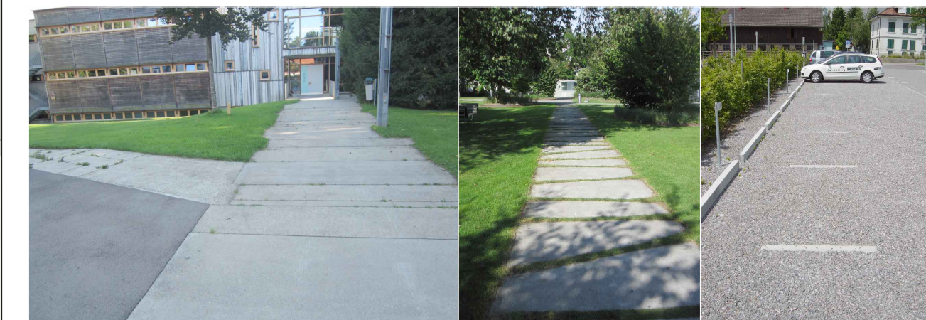
Friese Ortbeton mit offenen Fugen, Vorplatz West
