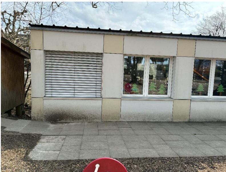
Probe 4: Fassadenplatte Eternit
