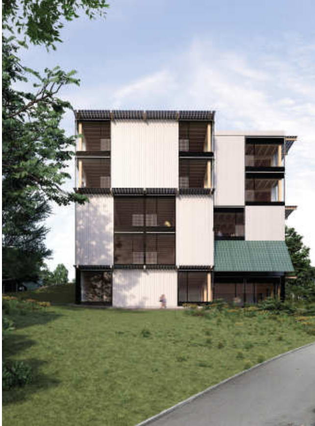
Von Fachwerk Neubau Tagesbetreuung Halden
