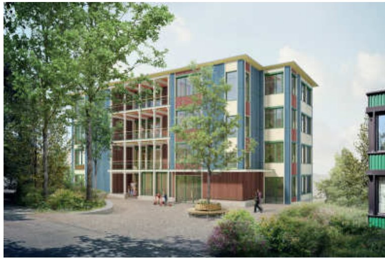
Blick vom Pausenplatz zur neuen Tagesbetreuung und zum neuen Kindergarten Halden
