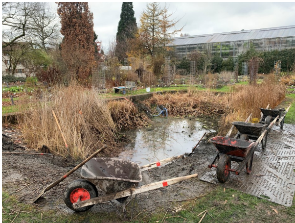
Arbeiten am Weiher im System.
