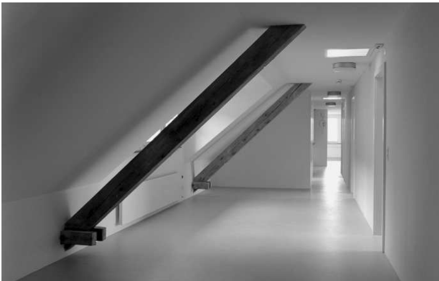
Gangzone im Dachgeschoss
