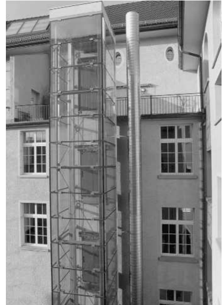
Neuer Lift im Hof
