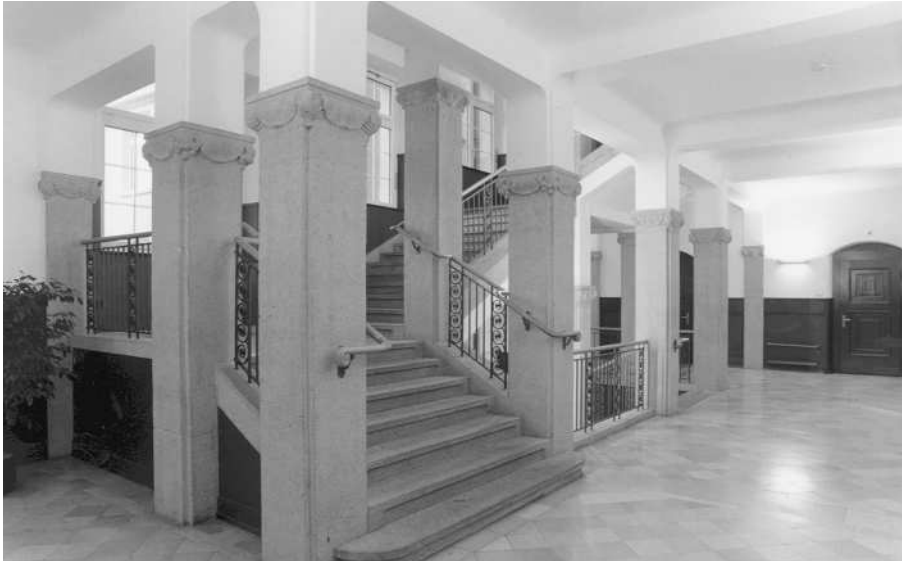
Treppenhaus denkmalgerecht renoviert
