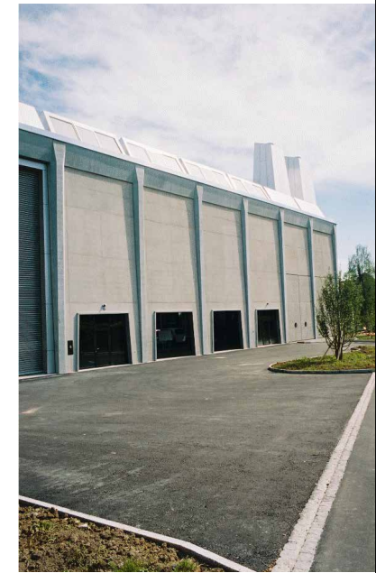
Die 2017 in Betrieb genommene Fernwärmezentrale Waldau
