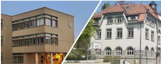
PS Rotmonten-Gerhalden Neubau KG und TB Iddastrasse
